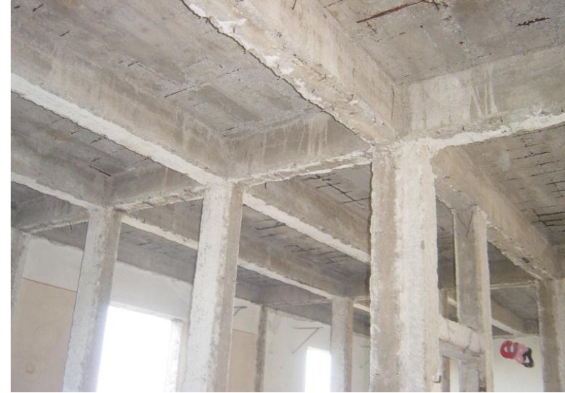
Schema strutturale: sistema a telaio Hennebique
