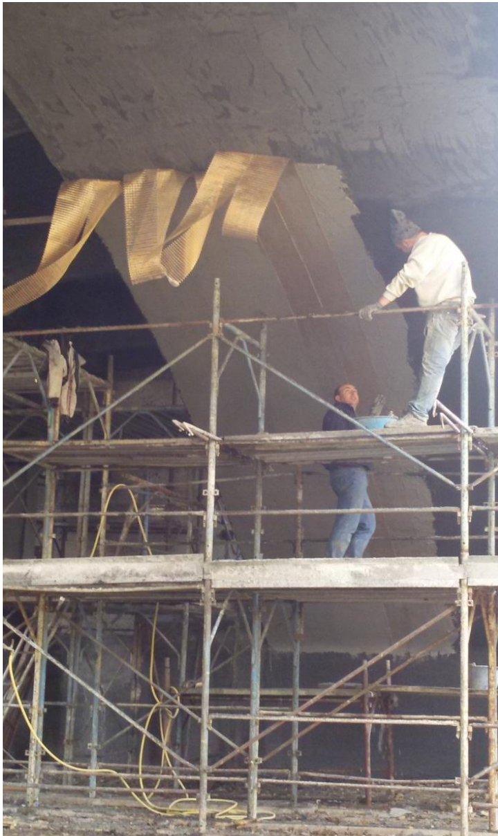
Nastro unidir. PBO 88 gr/mq + matrice inorganica calcestruzzo
