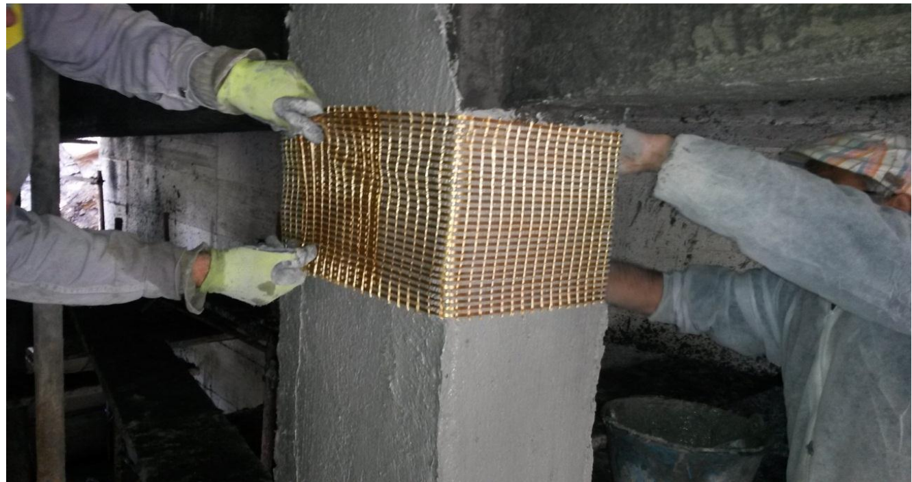
Nastro unidir. PBO 88 gr/mq + matrice inorganica calcestruzzo
