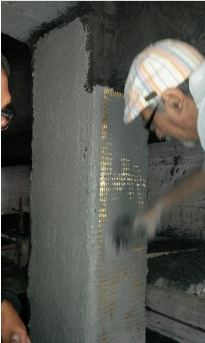
Nastro unidir. PBO 88 gr/mq + matrice inorganica calcestruzzo
