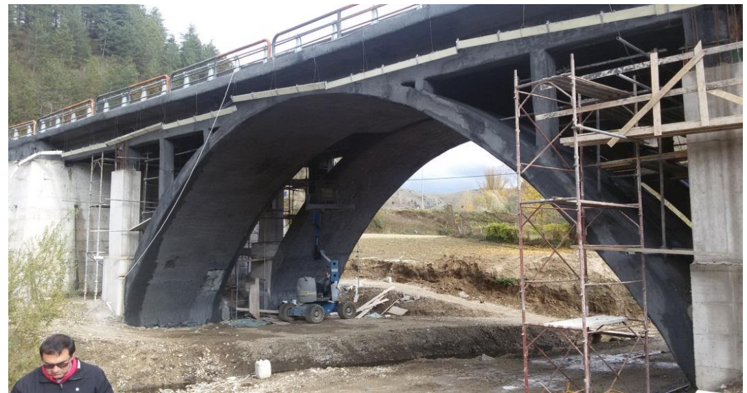
Malta tixotropica con fibre di PVA + inibitore di corrosione cementizio
