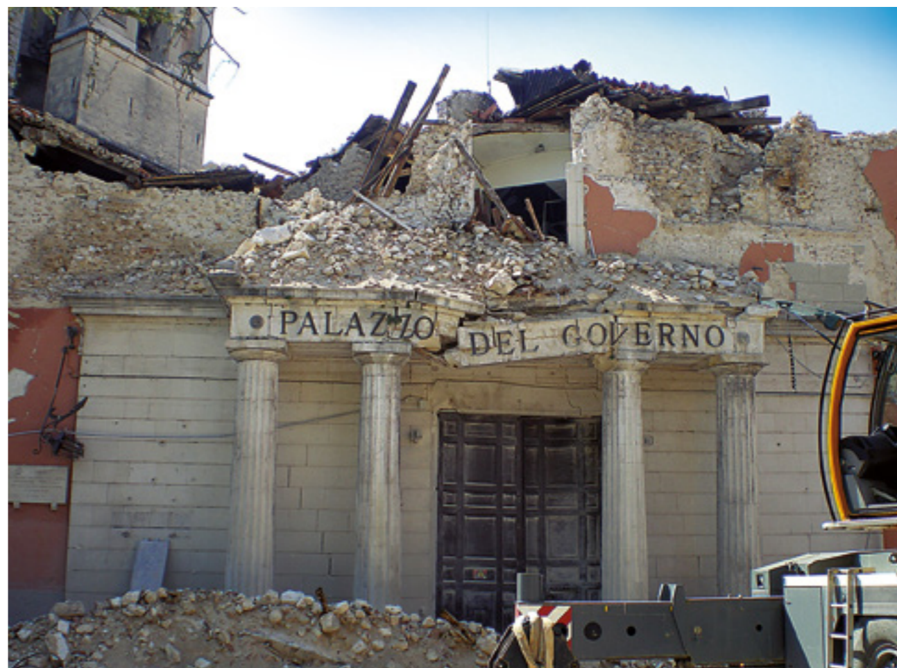
Un'immagine della Prefettura di L'Aquila dopo il terremoto del 2009 (M 5.9, 309 vittime), edificio strategico che avrebbe dovuto resistere e consentire il mantenimento delle proprie funzioni durante e dopo il terremoto.
